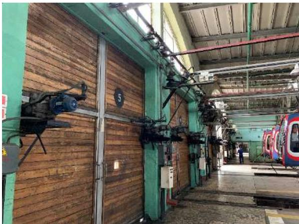
Рисунок 10 – Центральная система шин +825 В в депо
